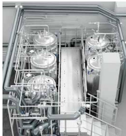
Konzeption, Konstruktion und Bau einer Pharmaanlage. Die Anlage besteht aus 15 Behältern und einer CIP-Anlage. Aufgebaut auf 7 Skids in 3 Räumen inklusive der Verrohrung der Anlage vor Ort. Besonderer Wert wurde auf die Reinigbarkeit der Anlage sowie der Produktrohrleitungen gelegt. Anlagenerstellung erfolgte unter Berücksichtigung der Druckgeräterichtlinie (DGRL), Maschinenrichtlinie (MRL) und ATEX-Richtlinie (ATEX). Inklusive Inbetriebnahme und Qualifizierung der Anlage.
